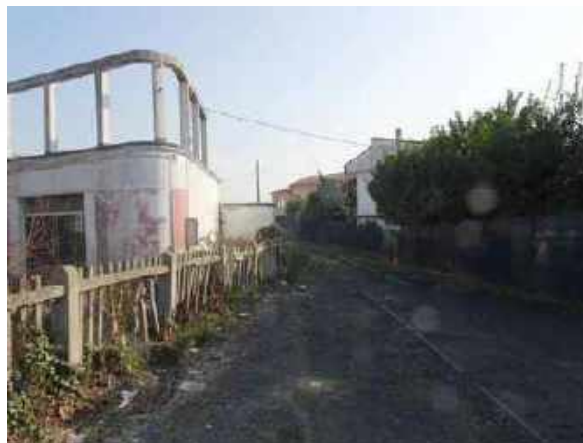
Foto n. 2 - verso via N. Golfini
