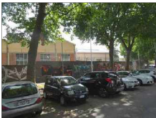
Foto n.4 - muro da riqualificare
